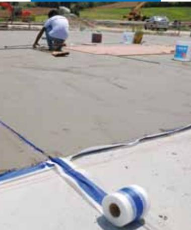
Impermeabilizzazione dei massetti con Mapelastic e Mapeband
