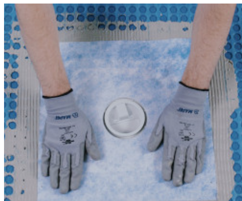
Impermeabilizzazione dello scarico con Drain Vertical/ Drain Lateral
