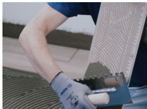
Posa della pavimentazione in ceramica o materiale lapideo con idoneo adesivo Mapei di classe non inferiore a C2
