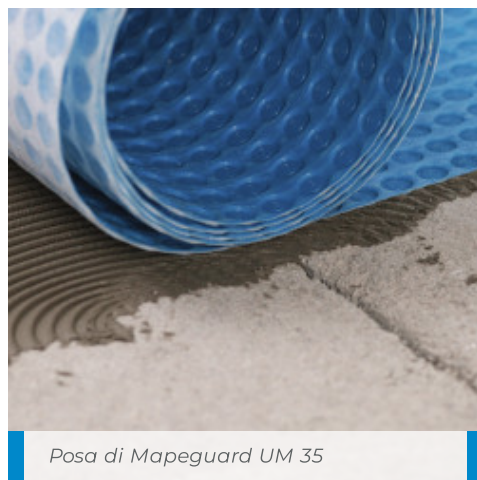
Applicazione dell'adesivo con spatola dentata n. 5
