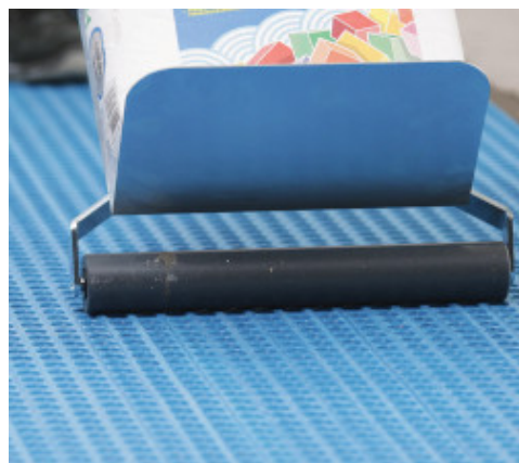
Pressatura di Mapeguard UM 35
