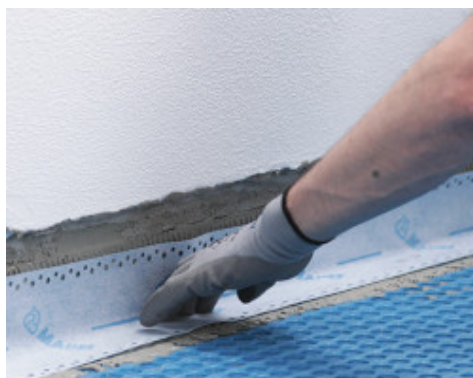
Impermeabilizzazione perimetrale con Mapeband Easy incollato con Mapeguard WP Adhesive
