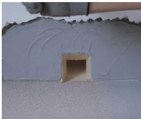
Impermeabilizzazione dello scarico con Drain Front
