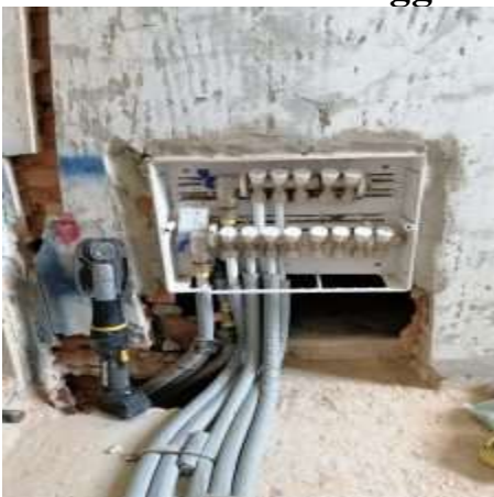
Pressatrice multistrato in cantiere
