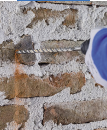
Realizzazione dei fori
