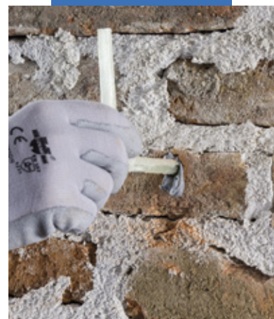
Posa di Mape-net EM Connector
