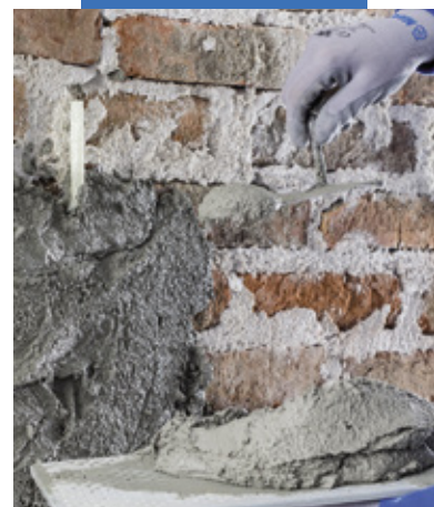
Applicazione del primo strato di MapeWall Intonaca & Rinforza
