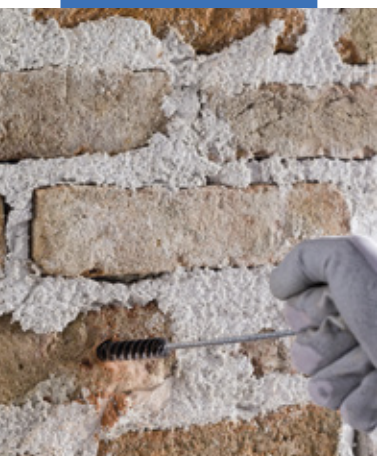
Asportazione delle polveri dai fori
