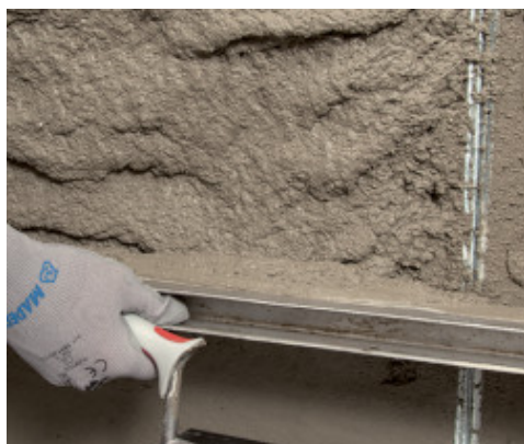
Staggiatura di MapeWall Intonaca & Rinforza
