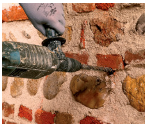
Realizzazione dei fori per MapeNet EM Connector
