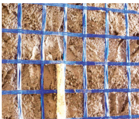
Posizionamento di MapeNet EM 40
