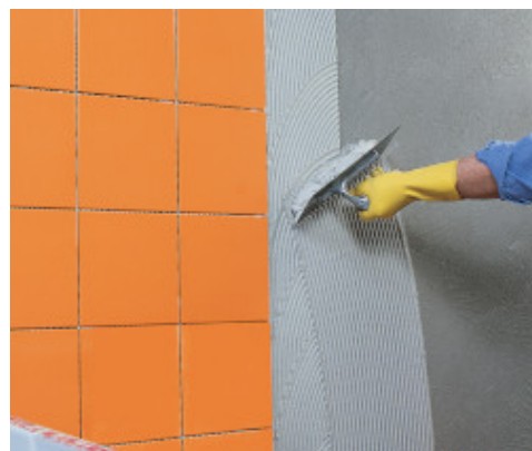
Incollaggio di rivestimento ceramico su MapeWall Intonaca & Rinforza
