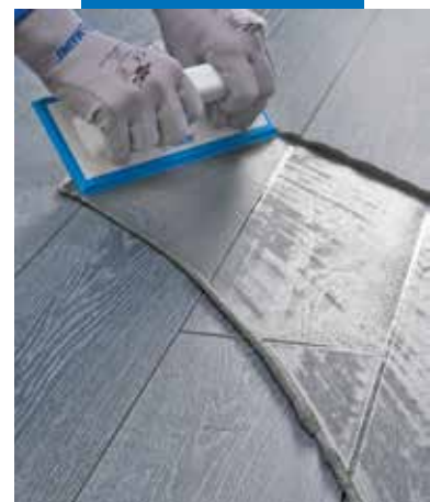
Stesura di Ultracolor Plus a pavimento con spatola di gomma su piastrelle in grès porcellanato effetto legno
