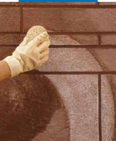
Pulizia e finiture delle fughe con spugna
