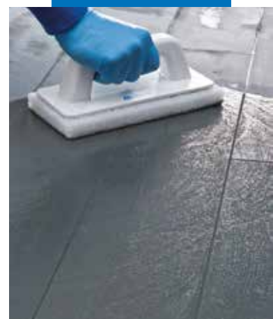
Pulizia delle fughe con Scotch-Brite (a prodotto parzialmente indurito)
