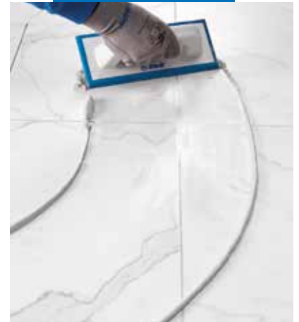
Stesura di Ultracolor Plus a pavimento con spatola di gomma su piastrelle in gres porcellanato effetto marmo
