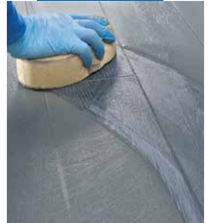
Pulizia e finitura delle fughe con spugna di cellulosa dura
