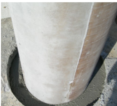
Inghisaggio di pilastro prefabbricato
