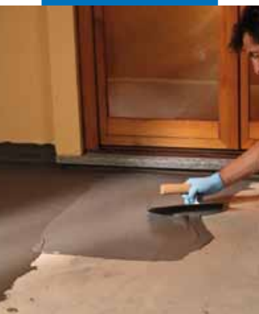
Impermeabilizzazione di terrazzo a spatola
