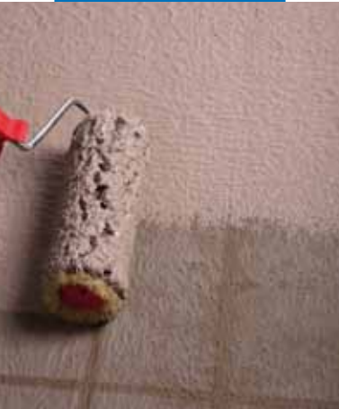
Impermeabilizzazione di terrazzo a rullo
