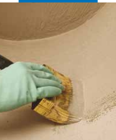
Impermeabilizzazione di dettagli a pennello
