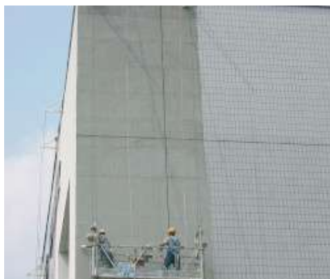
Applicazione di Planitop 200 su rivestimento in ceramica
