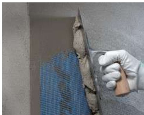
Applicazione del secondo strato di Planitop 200 con interposta Mapenet 150 su supporti di natura differente
