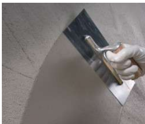
Applicazione di Planitop 200 su calcestruzzo
