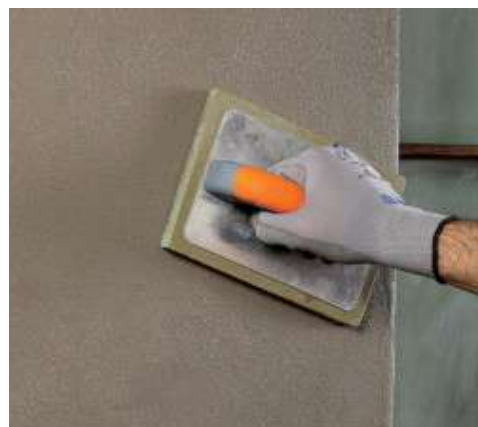
Frattazzatura di Planitop 200
